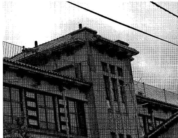
写真13 京都清水小学校塔屋
