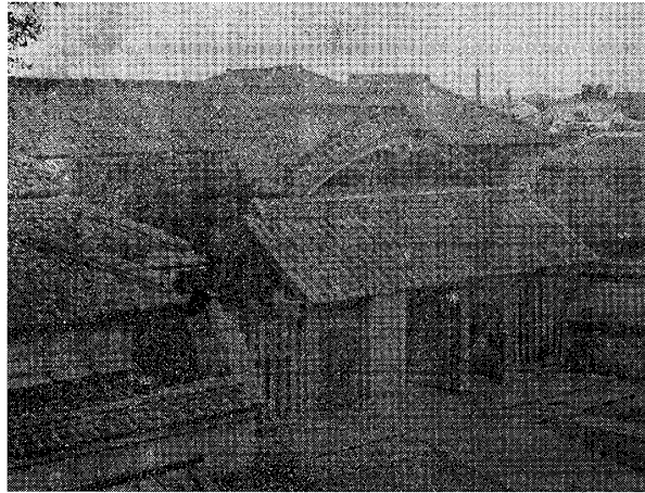
写真1 明治期の県庁舎
