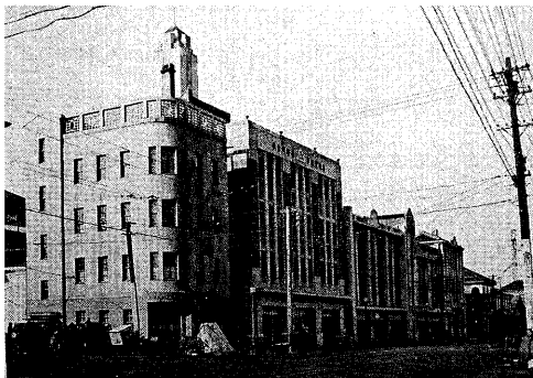
目貫ビル（竣工時）
