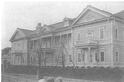
写真13 区公会堂・正面
