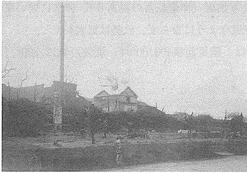
写真1 焼け跡・弁天町方向を見る
