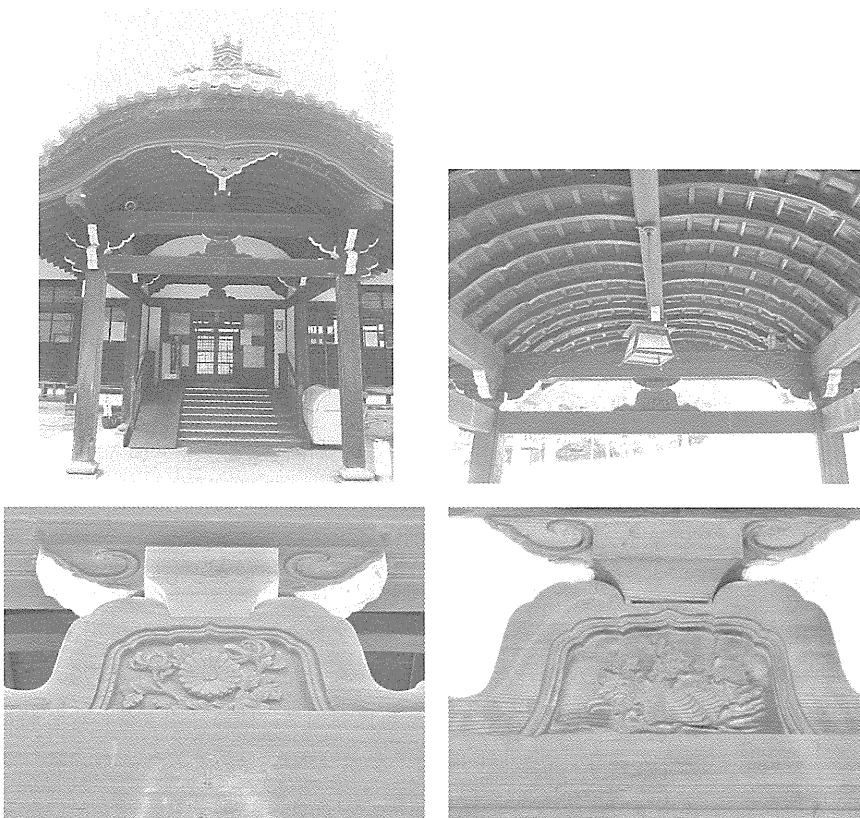
図19：玄関部分は美しい唐破風の屋根が設置されており、梁を支える蛙股の部分には菊（下左）と桐（下右）の彫刻が施されている。 （移築前の図面によると建物の両側にも玄関が2つあったが用途は不明）
